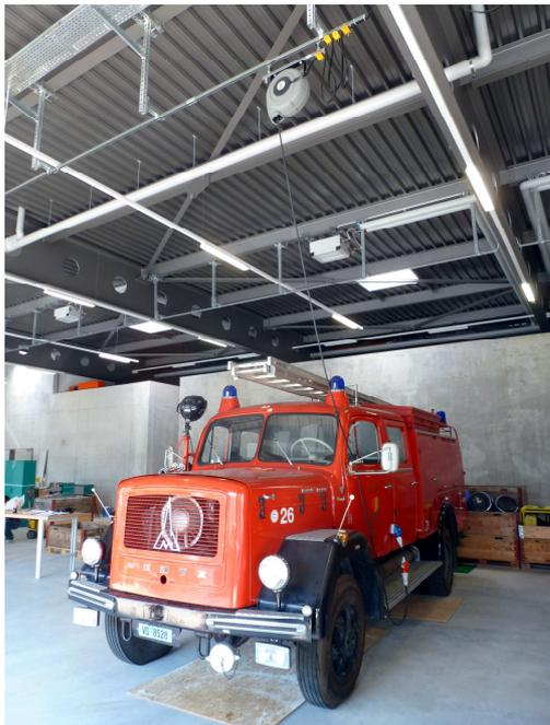
**Kabelwagen-Anlage mit mobilem Aufroller, kann seitliche jede Position anfahren**
