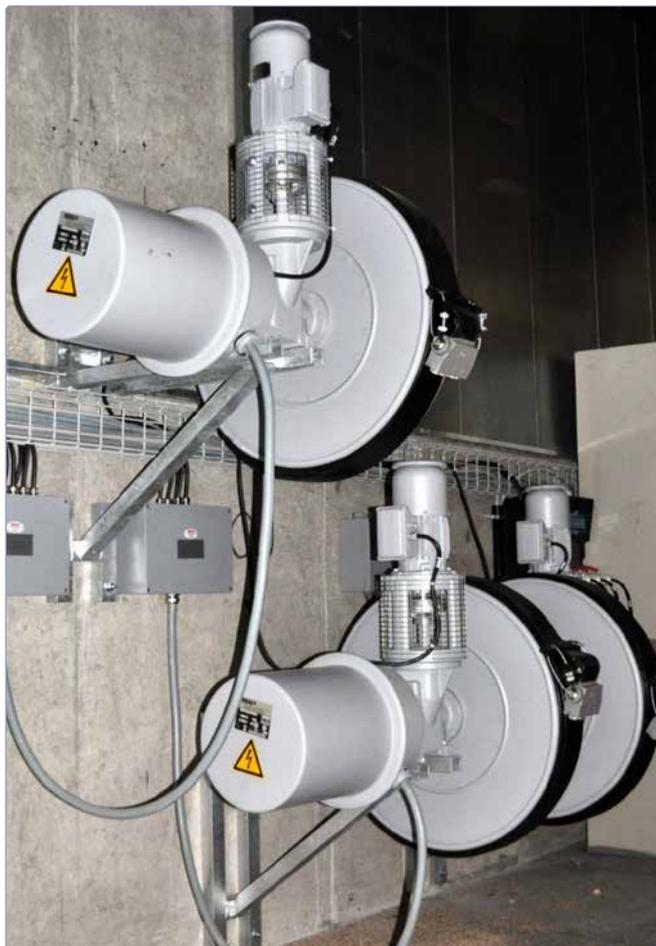
**Tambours de câble motorisés avec câble plat pour plateforme mobile, enroulement spiralé, montage incluant console et câblage par MIBAG SA**
