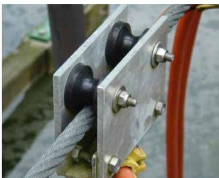
**Chariot de câbles ronds pour stations d'épuration, version spéciale en câble métallique.**
