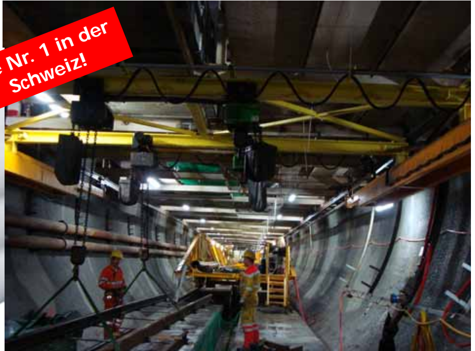
Flächenkran Tunnelröhre West und Ost Länge pro Röhre 100 m
