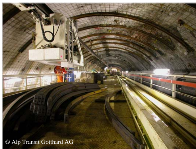
Tunnelbau ARGE Amsteg NEAT Nachläuferkonstruktion, Schleifleitung für Logistikkran, Länge 125 m, Umgebung staubig und feucht
