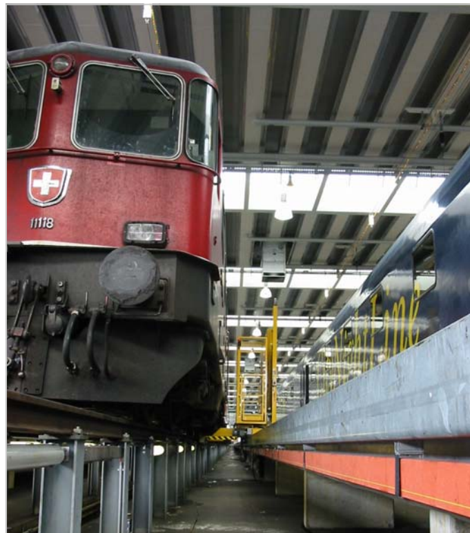
SBB Herdern Zürich Verschiebeanlage für mobile Hebebühne über 250 m, 4 Anlagen à 250 m
