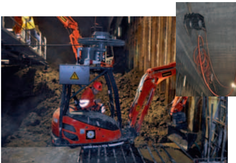
Der Hutter Kubota KX61 Bagger mit der im Drehpunkt montierten Federleitungstrommel wird direkt von der Tunneldecke mit einer fahrbaren Seiltrommel mit Gegengewicht in massiver Konstruktion versorgt. (Bild: MIBAG AG)
