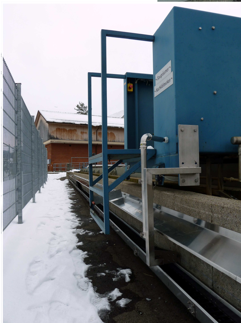
Massiver Mitnehmerarm mit Stahlplatte an Räumler angeschraubt, Ansicht Regendach mit Führungskanal
